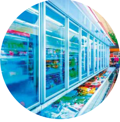
Soğutma ve HVAC
